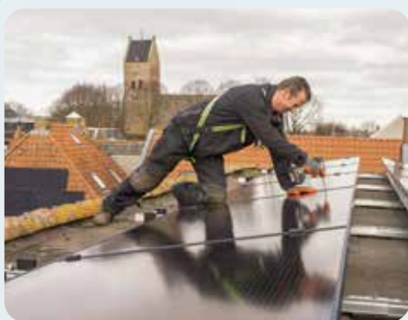
Zonnepanelen laten plaatsen
